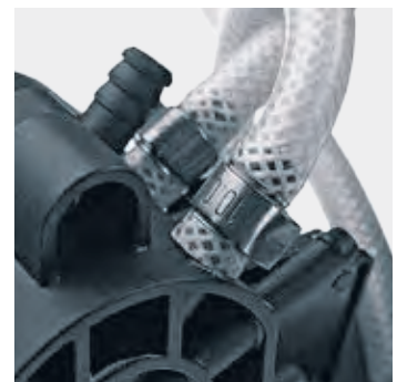
Nahrungsmittel- und Getränkeindustrie: Anschluss in einem Getränkeautomat
